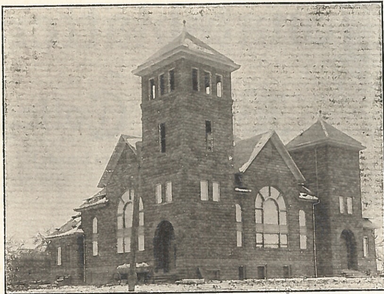
Die Gnadenkirche in Pandora, Ohio.
